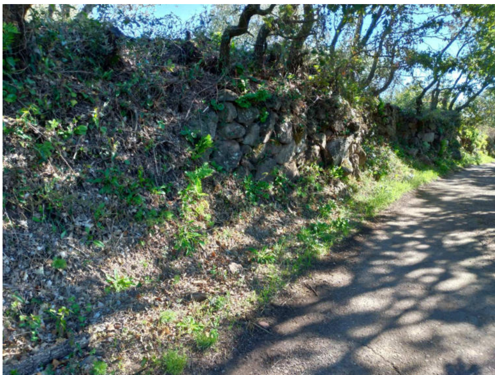
Foto 2: Opere in muratura a secco da sottoporre a manutenzione
